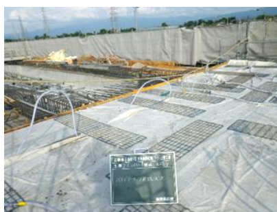
写真-3 クーリング状況
