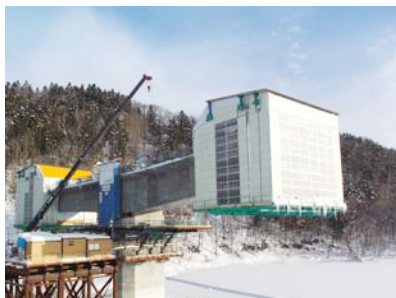
写真-5 移動作業車養生状況
