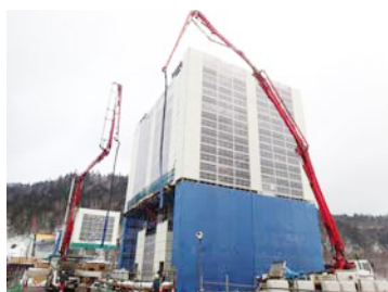
写真-3 柱頭部防寒養生囲い
