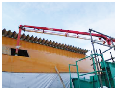
写真-6 移動作業車屋根と打設開口
