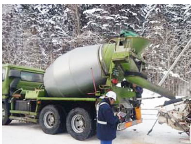
写真-1 アジテータ車のドラム部保温
