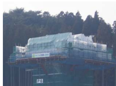
写真－5 防災シートによる囲い
