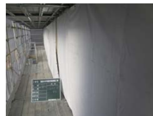
写真－7 足場の防災シート囲い
