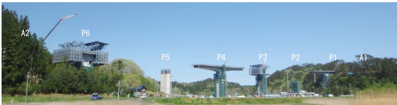
写真－8 夏井高架橋工事進捗 (平成 29 年 5 月)
