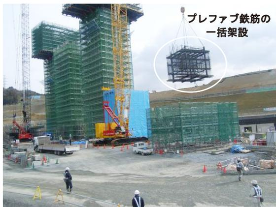
写真-4 プレファブ鉄筋架設状況
