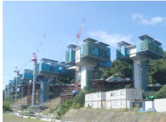
写真-3 張出し施工状況
