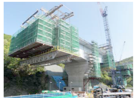
写真-2 鉄筋先組対応ワーゲン
