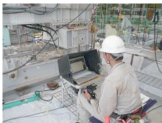
写真-6 緊張管理状況
