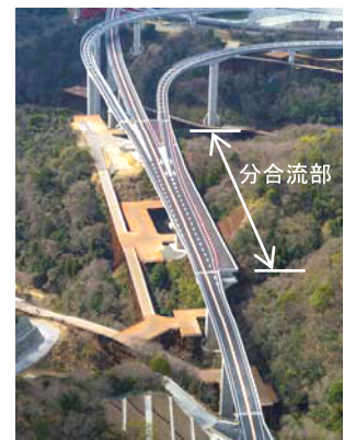
写真-1 雄ノ山高架橋全景
