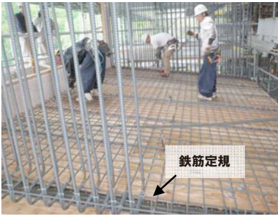
写真-3 鉄筋先行組立て状況
