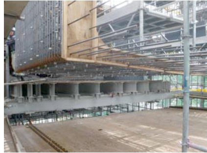
写真-4 先組鉄筋吊上げ状況
