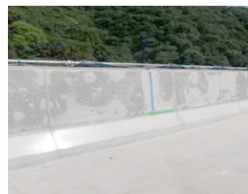
写真-9 養生状況
