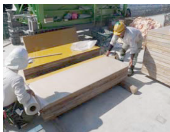
写真-8 貼付作業
