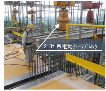
写真-5 先組鉄筋引込み状況
