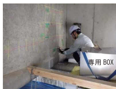
写真-4 計測状況
