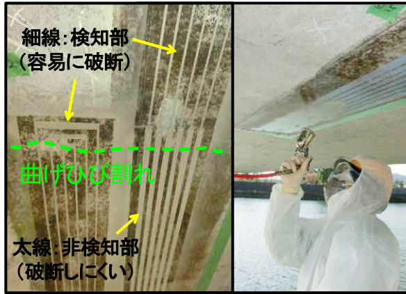
図-9 導電塗料の塗布状況
