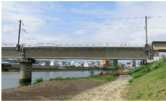
図-5 対象橋梁 PC 単純箱桁 (支間長 37.2m)
