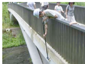
写真-7 表面洗浄の状況
