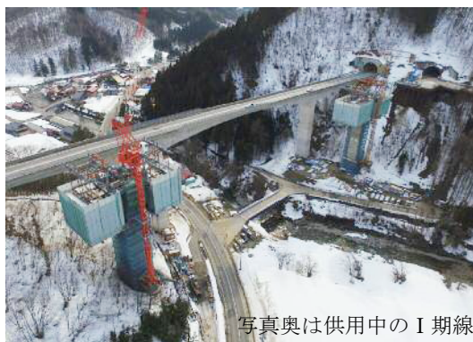
写真-3 黒谷橋冬期休止期間明けの状況
