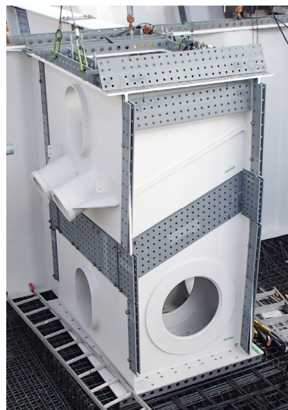
写真-1 斜材定着部の構造
