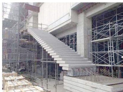
写真－15 PC階段架設状況
