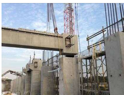
写真-5 レンコン柱頭部
