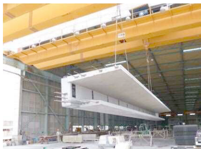
写真－12 吊り上げ状況
