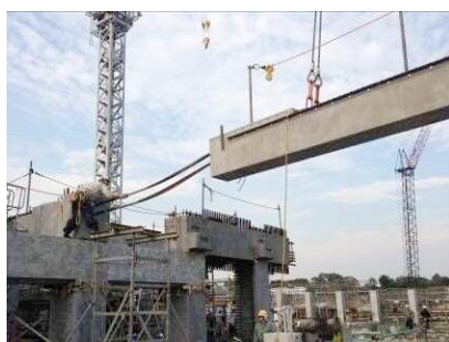
写真-4 PCケーブル挿入
