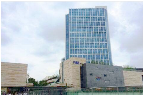
写真-1 建物外観
