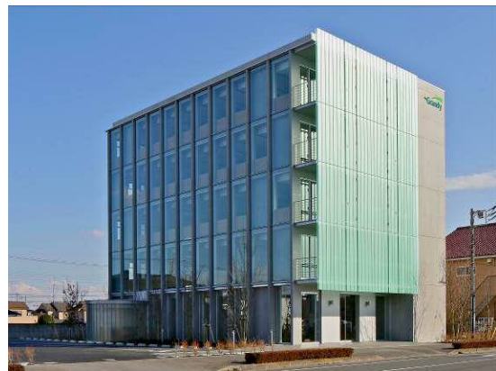
写真-10 完成写真
