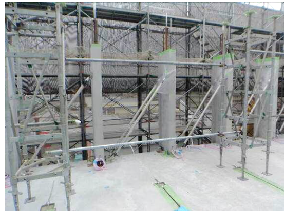
写真-8 柱部材セット状況
