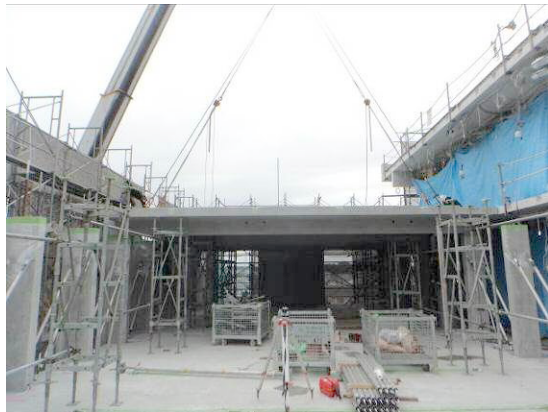
写真-9 梁部材セット状況
