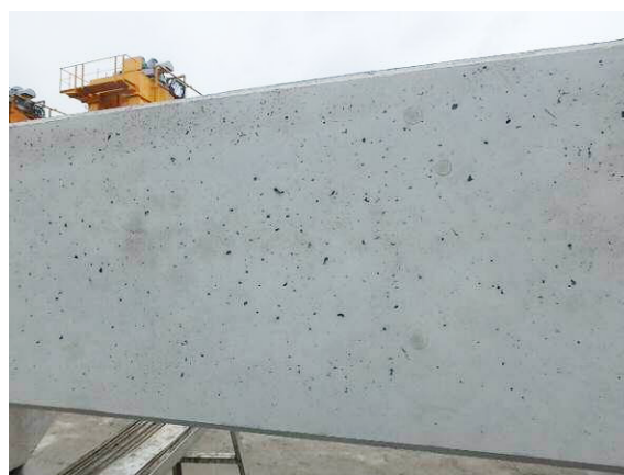
写真-4 試験打設
