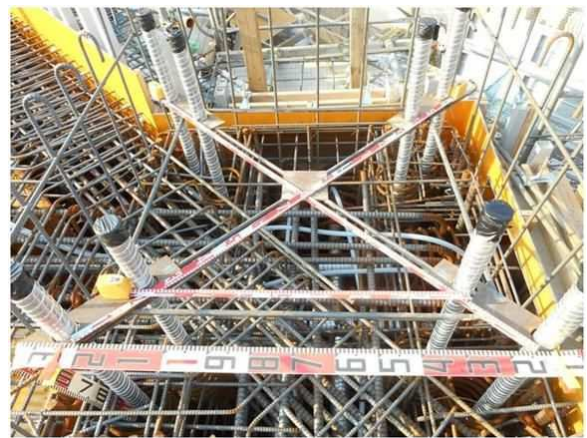
写真-2 PC鋼棒設置テンプレート
