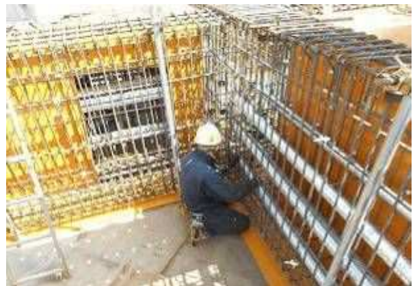
写真-3 シース施工状況
