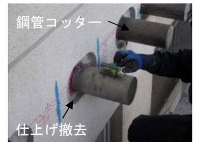
写真-1 鋼管コッター取付状況
