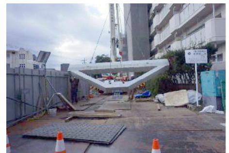
写真-2 PCa 梁建方状況
