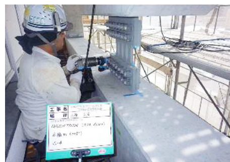
写真-5 ダンパ材取付け状況
