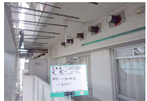
写真-1 鋼管コッター取付け
