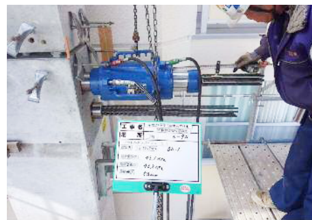
写真-4 PCa 梁緊張作業
