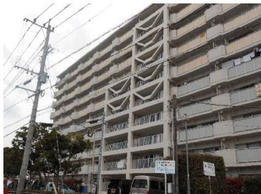
写真-6 補強後外観 (A棟)
