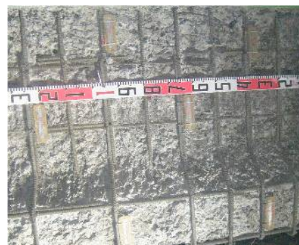
写真-4 設置状況
