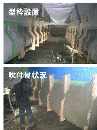
写真-5 施工状況
