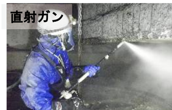
写真-3 はつり工
