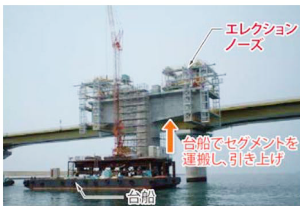
P1-P4間は台船にてセグメントの海上運搬。 エレクションノーズにて直下吊り
