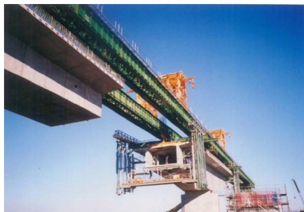
P5-P12間は軌道装置でセグメントを橋面運搬。 A2側から架設桁にて順次張出し架設
