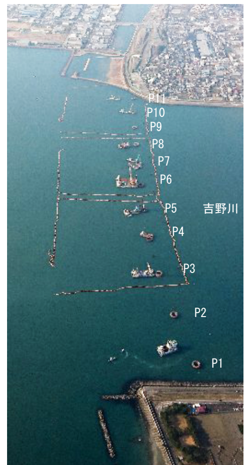
写真-4 施工状況 (平成29年3月)
