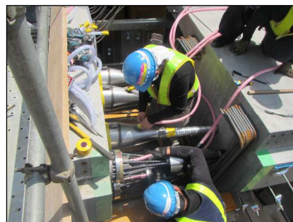
写真-2 PC鋼材接続状況
