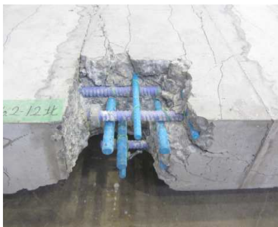
写真-6 定着部の状況 (直線定着タイプ)
