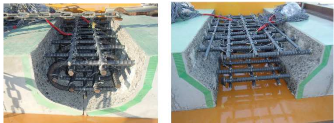
写真-4 静的曲げ試験体継手部状況
