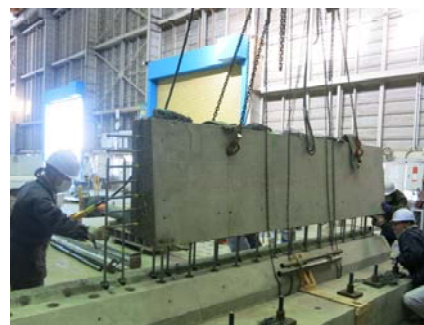
写真-1 PCa壁高欄の組立て
