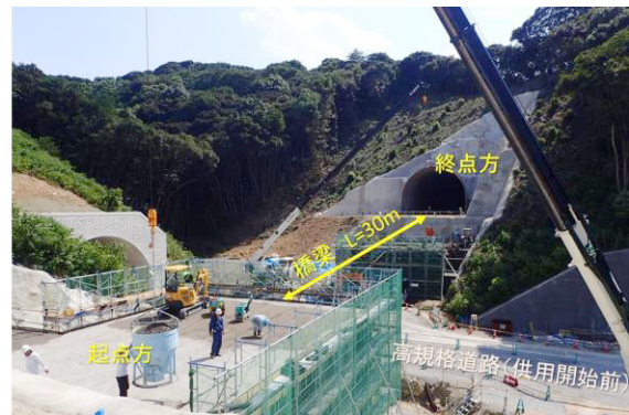
図-3 PC桁を用いたGRS一体橋梁の現地状況
