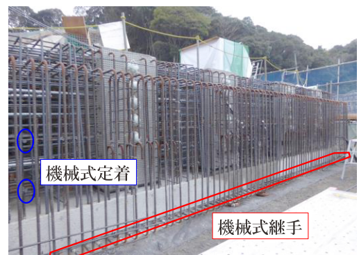
図-7 接合部配筋状況
