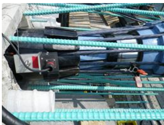
写真-1 ケーブル伸び計測状況 (E橋)
