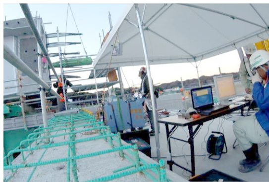
写真-2 緊張作業状況 (H橋)
