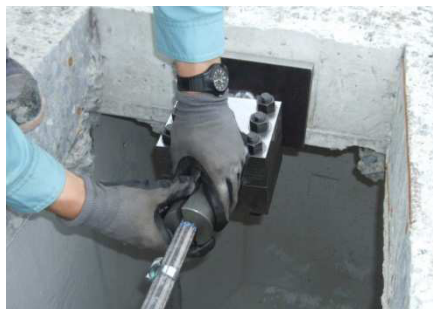
写真-6 フィクスチャ取付け
