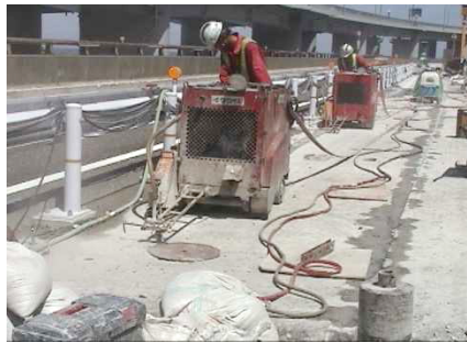
写真-12 コンクリート切断
