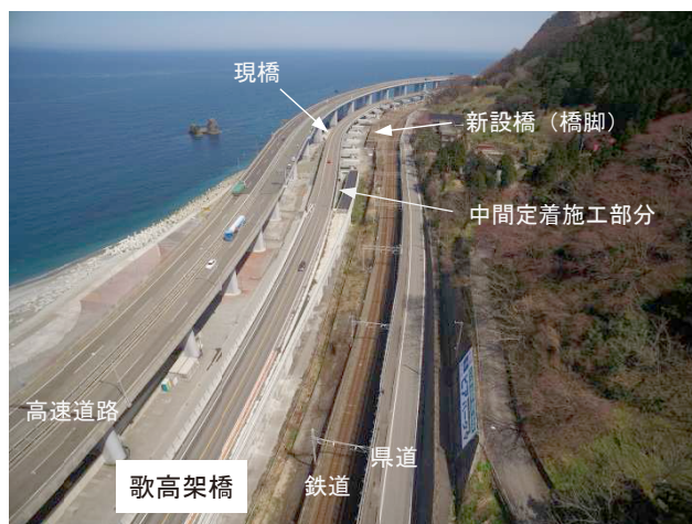
写真-1 橋梁全景（終点側より）
