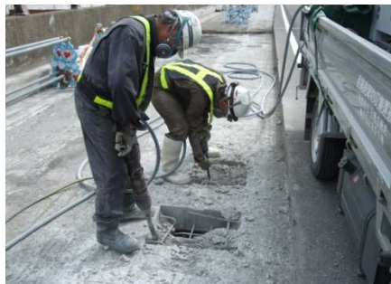
写真-4 コンクリートはつり
