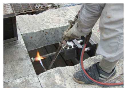
写真-9 PC鋼材切断
