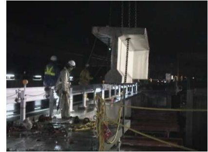
写真-13 主桁撤去
