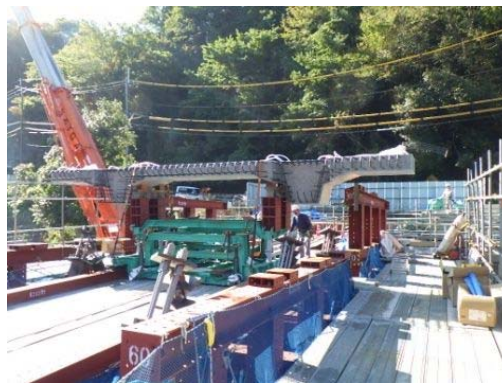
写真-4 PCa 上床版架設
