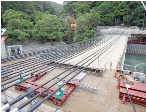
写真-2 1次ケーブル架設
