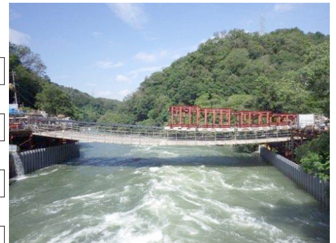
写真-3 PCa吊床版架設
