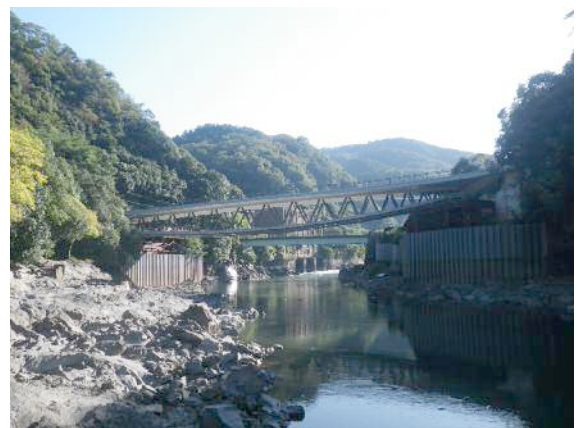
写真-3 完成写真
