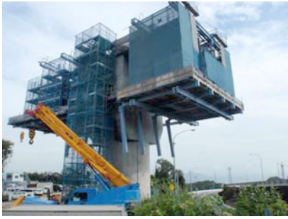
写真-3 中央足場組立
