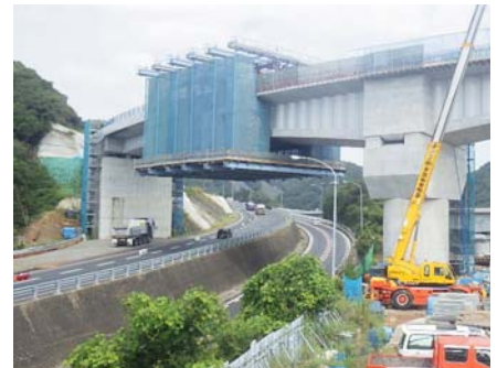
写真-5 防護台車の移動
