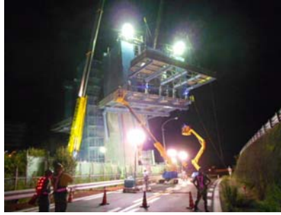
写真-4 前方作業台組立
