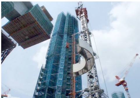
写真-1 PCa部材架設状況
