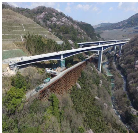
写真-3 安威川橋全景
