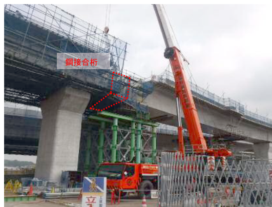
写真-8 鋼接合桁架設状況
