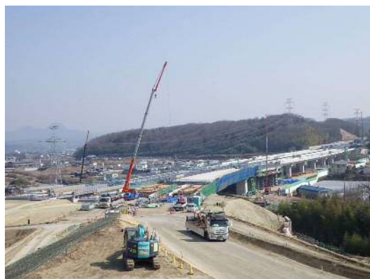
写真-9 全景 (GランプA2背面より)
