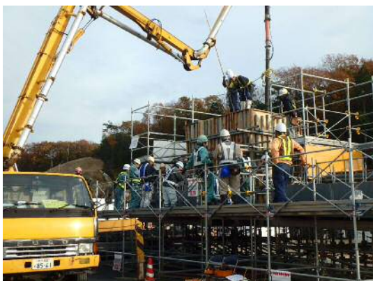
写真-4 打設試験状況 (全景)
