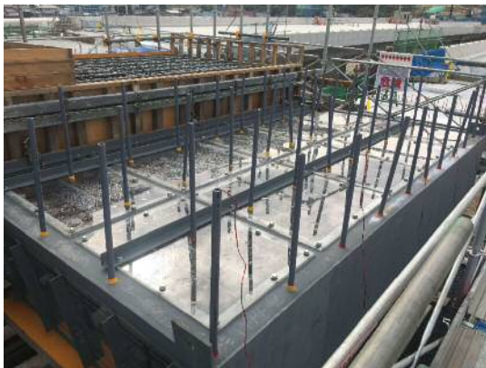
写真-2 下フランジ側試験体
