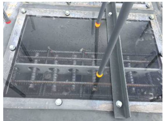
写真-3 試験体鋼殻セル部
