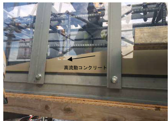
写真-5 打設試験状況 (近接)
