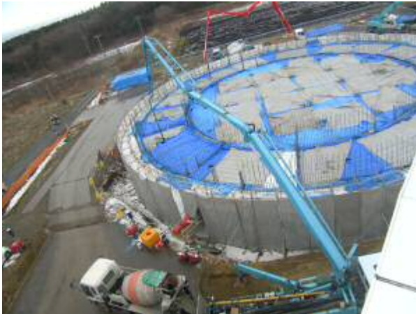
写真-1 給熱養生全景
