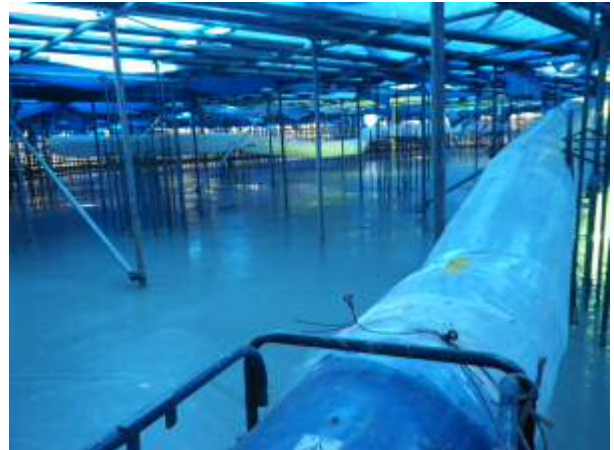
写真-2 給熱養生状況
