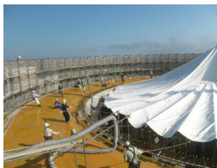
写真-4 型枠上の展設作業
