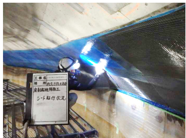
写真-3 屋根内面炭素繊維貼付け作業状況
