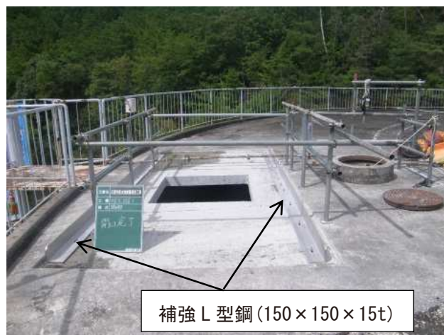
写真-2 開口部補強状況
