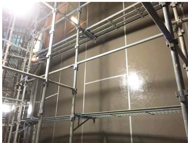
写真-4 FRPシート貼付け状況
