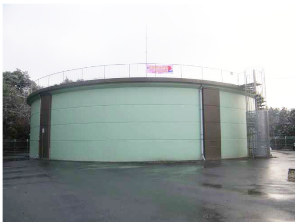
写真-5 外部完成写真
