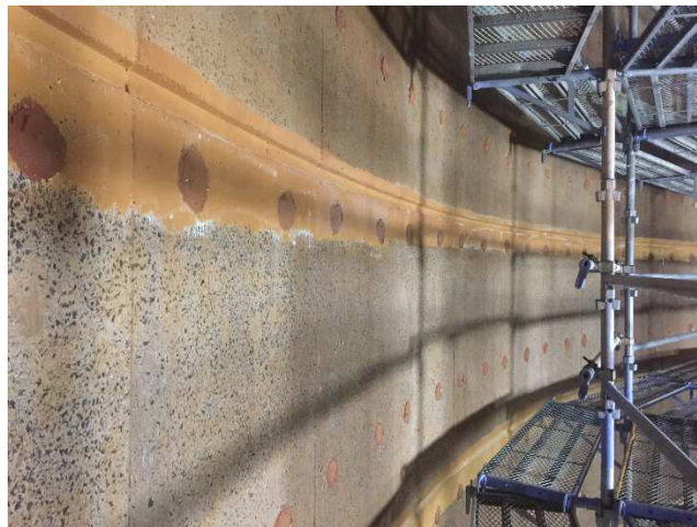
写真-1 内タンク側壁内面防水前状況
