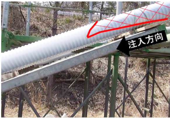
図-10 下り25度勾配での注入状況
