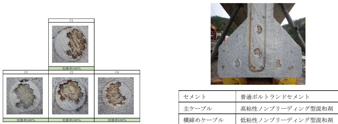
図-4 切断面調査状況
