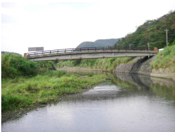
写真-3 アヒン橋全景 (撤去前)
