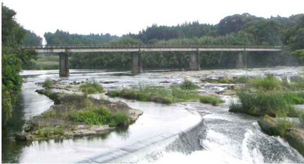
写真-1 撤去前の曾木大橋
