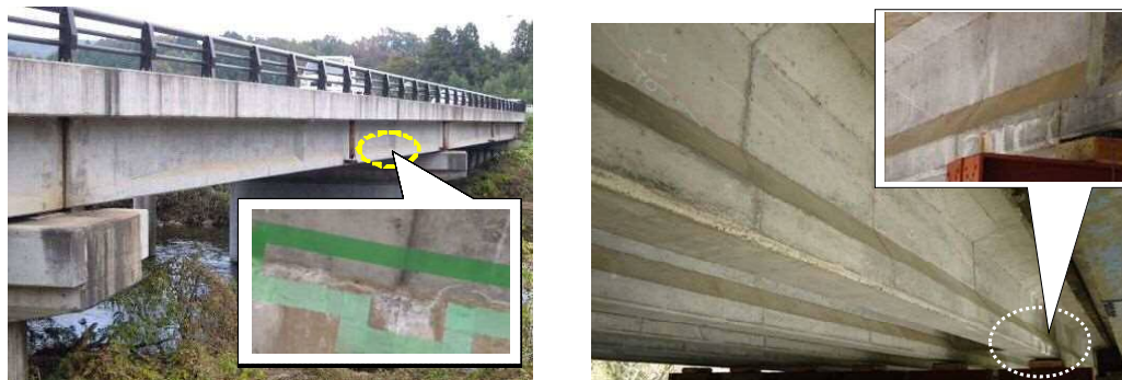
写真-1 対象橋梁の外観 (左: H橋, 右: S橋)
