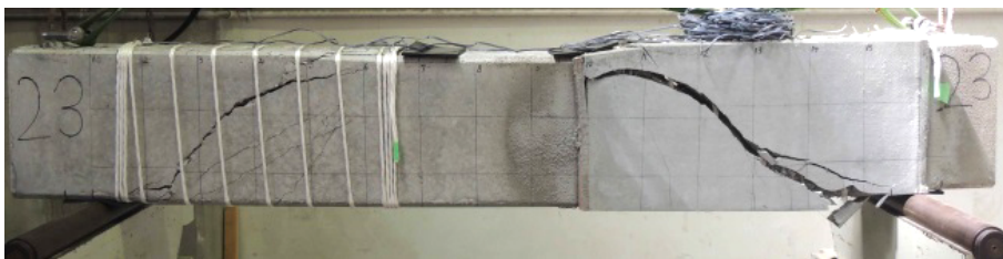
写真-4 破壊状況 (No. 23)
