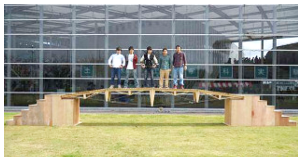
写真-14 木製張弦梁構造歩道橋(2014年)
