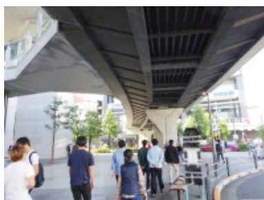
写真-5 200N/mm 2 のコンクリートを使用したアキバブリッジ
