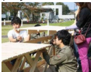
写真-11 協働によってユニットを組立てる
