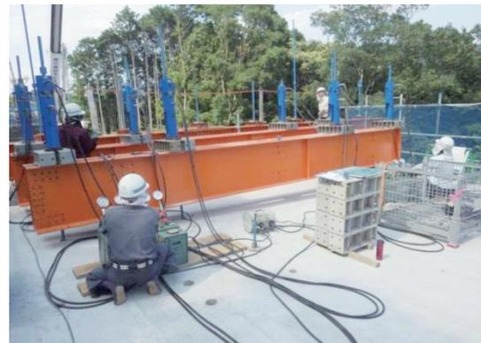
写真-1 PC鋼棒の緊張
