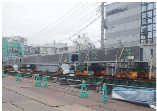
写真-1 地組み架台設備
