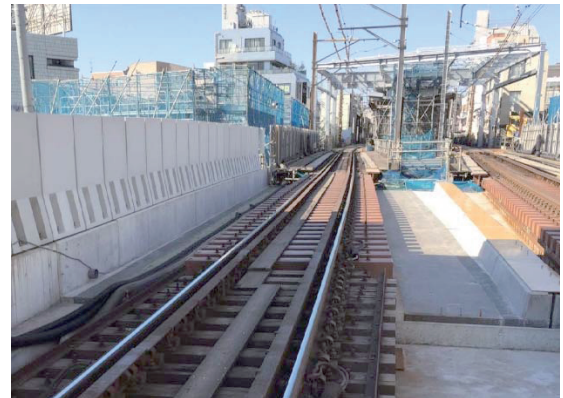
写真-4 施工完了
