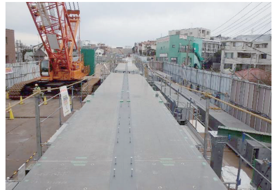
写真-2 2主桁一体化
