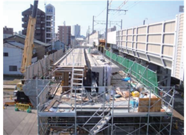
写真-3 主桁製作(2本目)
