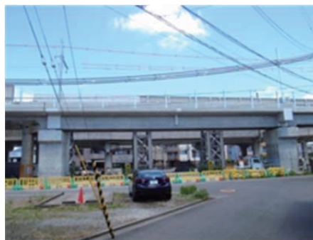
写真-6 北福井第2Bv-Ctp4 完成写真
