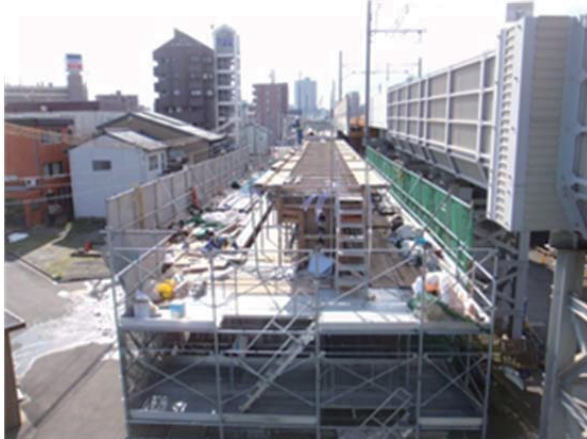
写真-2 主桁製作(1本目)
