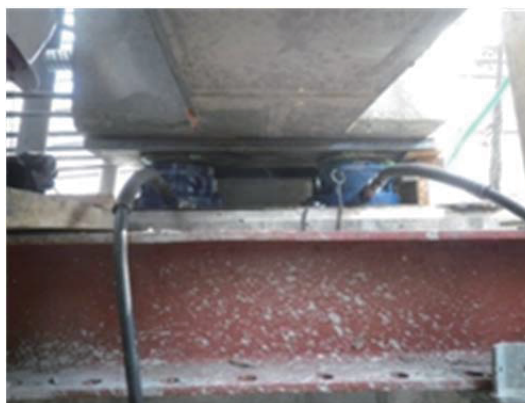
写真-5 ジャッキアップ状況
