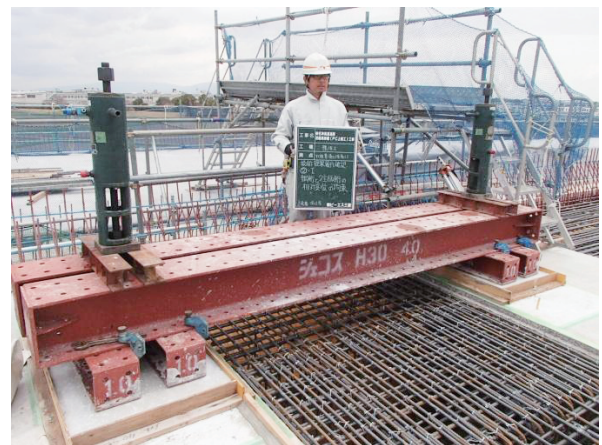
写真-1 固定鋼材設置状況
