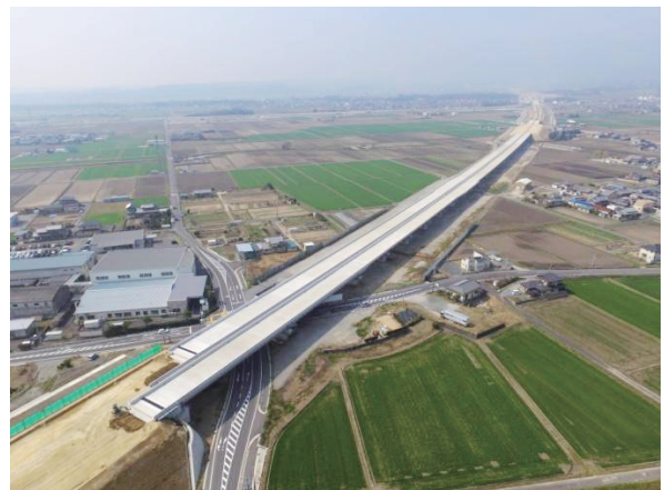
写真-2 工事完成写真
