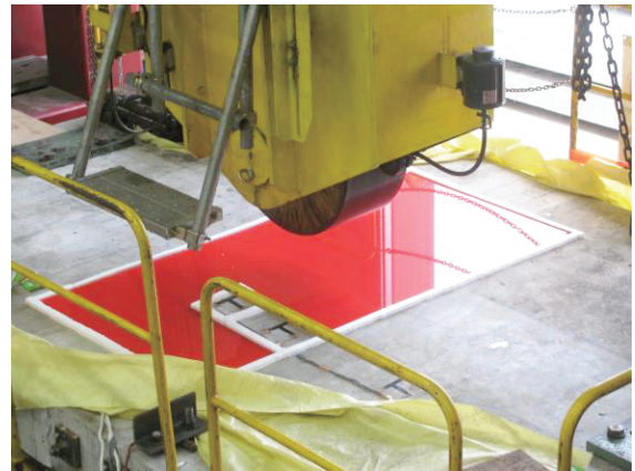
写真-2 水張り試験状況
