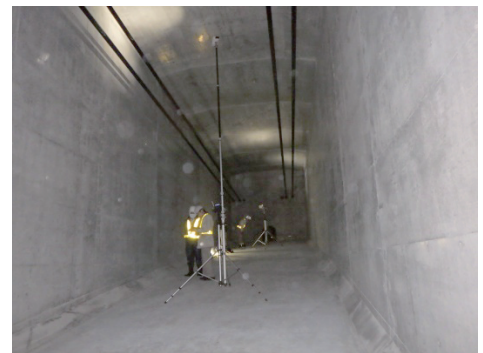
写真-8 PC 箱桁内における高所型を用いた点検
