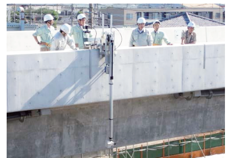
写真-5 自走式点検ロボットカメラを用いた点検状況
