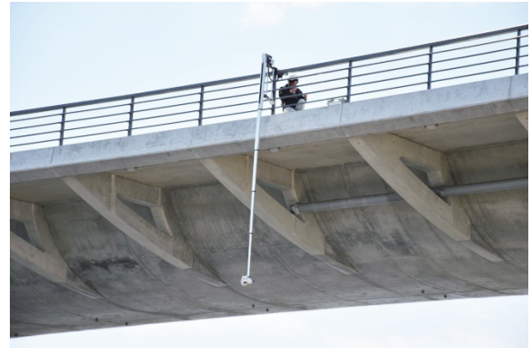
写真-7 懸垂型点検ロボットによる点検状況
