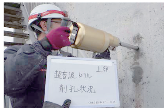
写真-3 調査状況（削孔調査）
