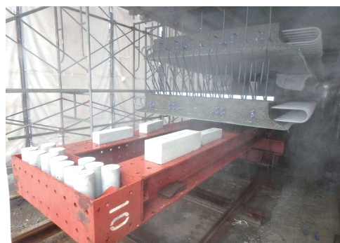
写真-1 ミスト養生状況
