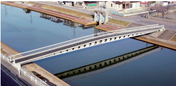
図-1 酒田みらい橋の外観
