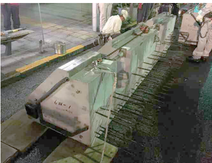
写真-7 袖壁部材の揚重
