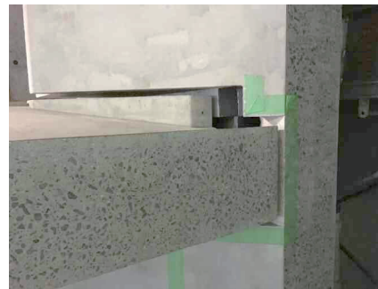
写真-11 庇と袖壁収まり
