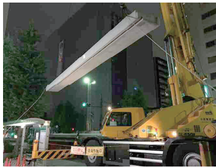
写真-8 庇部材の地切り
