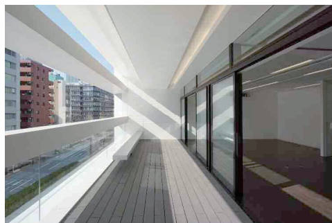
写真-15 PCaPC ベンチ
