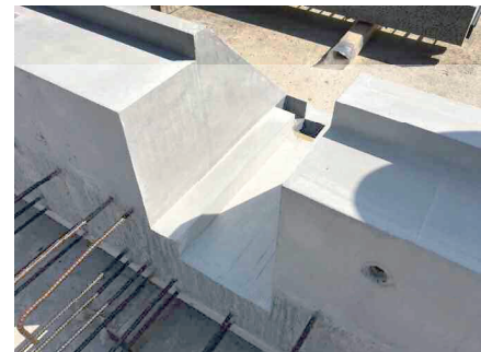
写真-5 袖壁切り欠き部
