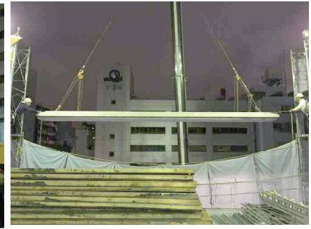
写真-9 庇部材の揚重
