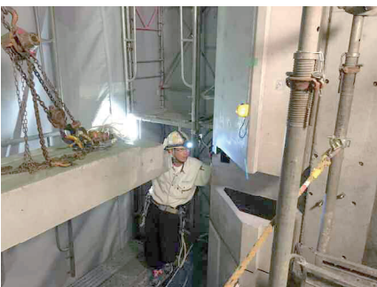
写真-10 庇部材の架設
