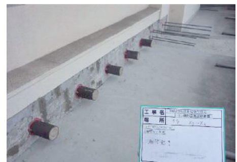
写真-1 鋼管コッター取付け
