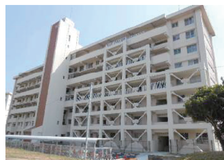
写真-6 補強後外観
