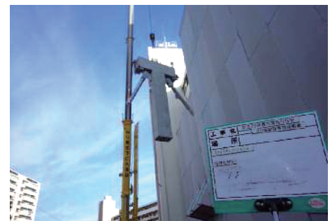
写真-2 PCa柱建方状況
