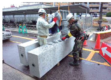
写真-3 PCa 梁建方状況
