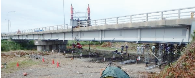
写真-1 載荷径間全景
