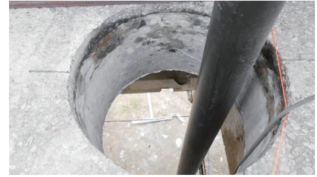
写真-2 床版削孔部
