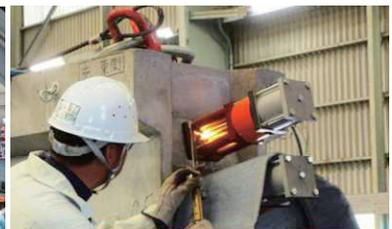
写真-4 PCケーブル切断
