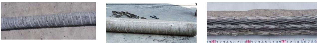
写真-4 グラウト充填状況 (左から: 上床版シース, 下床版シース, 下床版 PC 鋼より線部)
