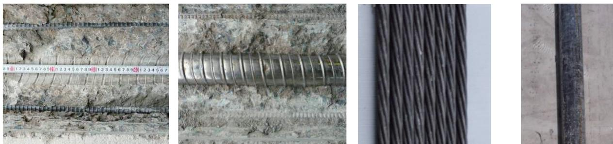
写真-3 腐食調査状況 (左から: 下床版上筋, 下床版シース, 下床版 PC 鋼より線, 上床版 PC 鋼棒)
